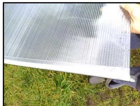
Obrázek č. 9 - Instalace U-profilu
