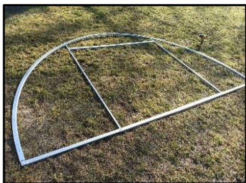
Obrázek 1 - Schéma montáže čel konstrukce – pohled z vnitřku
