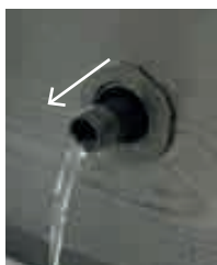
5. Vytažením ventilu se průtok vody sníží
