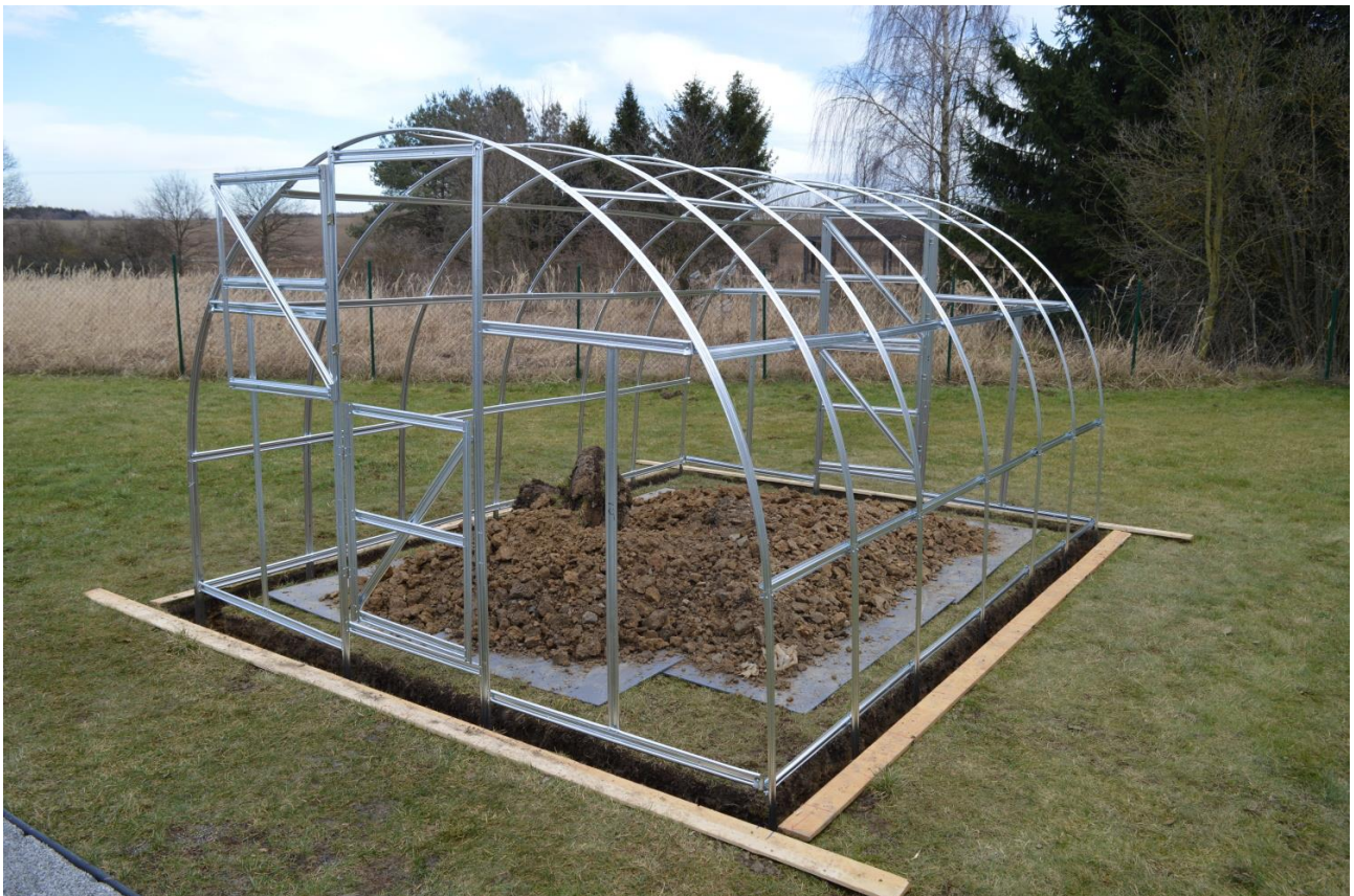
Ilustrativní foto způsobu kotvení jednoho z větších modelů – naprosto shodný postup (jednotlivé profily se mohou svou polohou odlišovat v závislosti na modelu, rozměru a na roku výroby skleníku )
